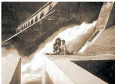
Le sorelle Tilocco, figlie del capocentrale, davanti alla diga
